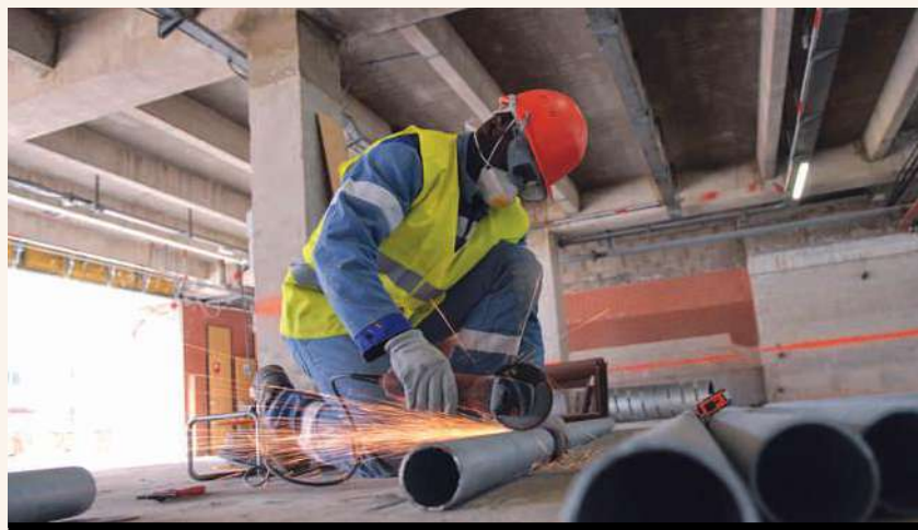
LE CHANTIER DE RÉNOVATION du siège de L'Oréal à Clichy emploie des personnes issues de quartiers en difficulté.
